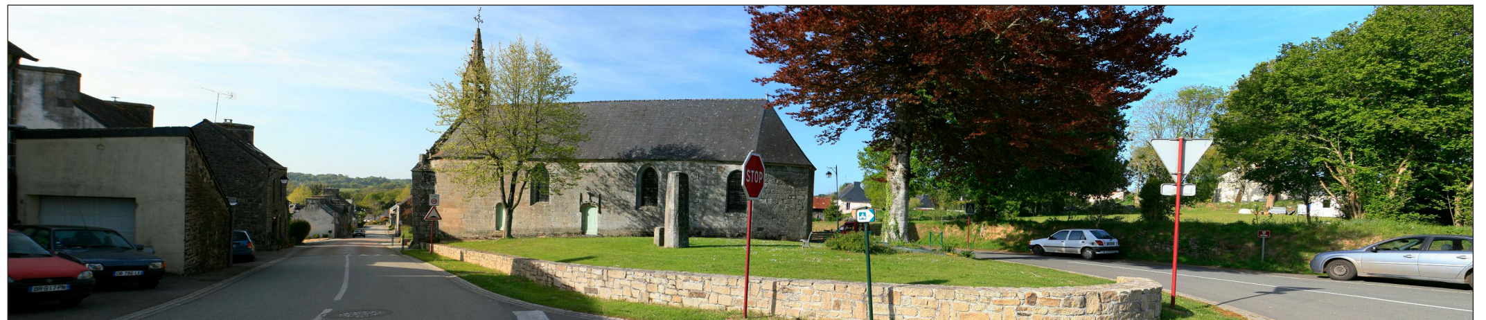
Vue du site avant projet
