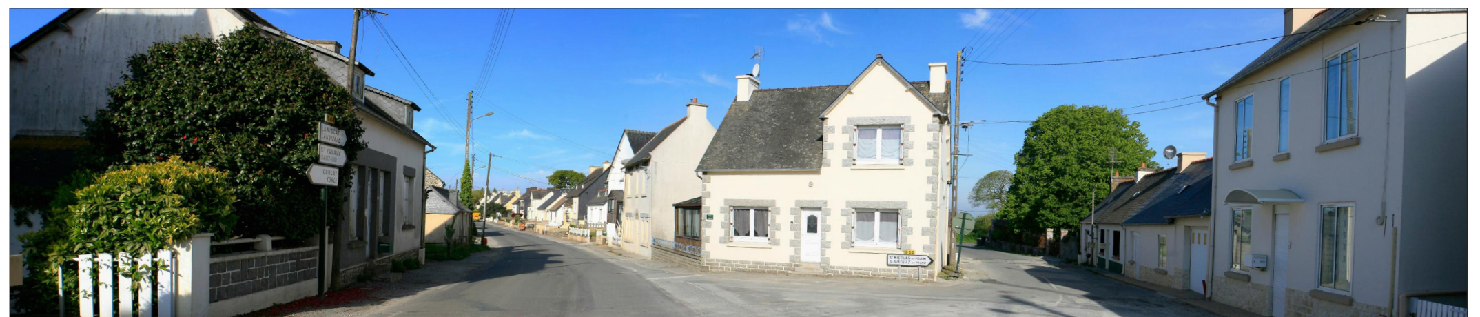
Vue du site avant projet
