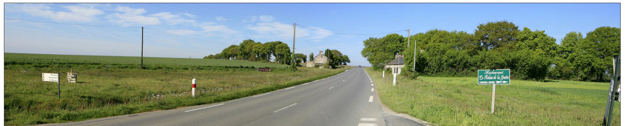
Vue du site avant projet
